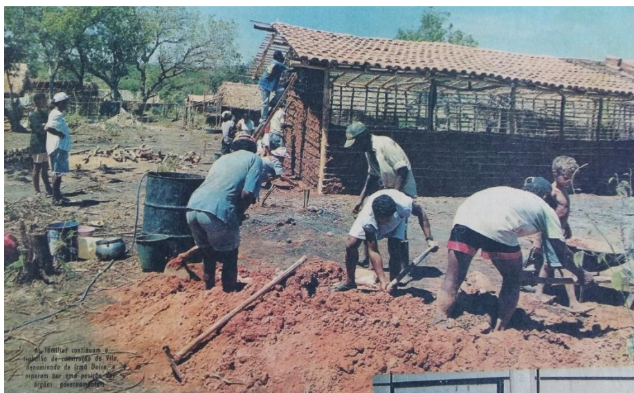
Foto: Moradores da Vila Irmã Dulce trabalho em formato de mutirão na construção de Escola.
