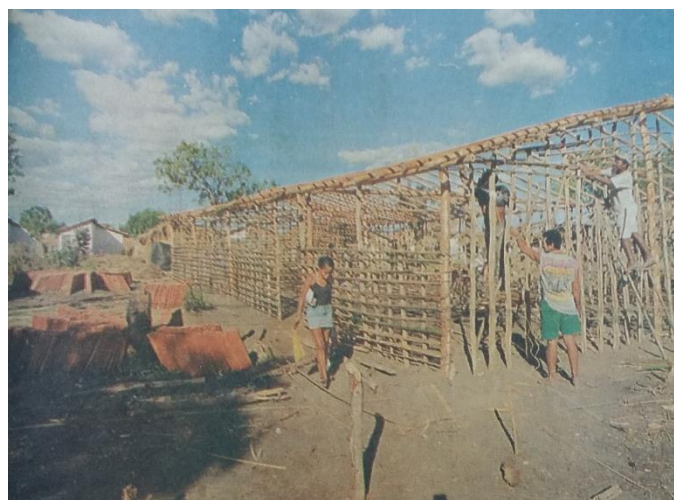
Foto 02: Construção de Casa de pau-a-pique na Vila Irmã Dulce. Fonte: Jornal O Dia, 24 ago 1998.
